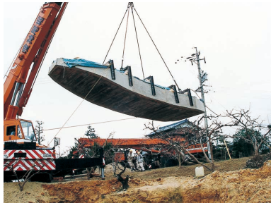
桃山第8号窯移設工事
