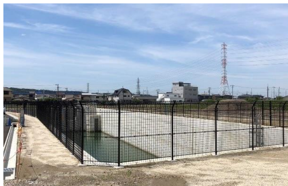
熊野桜佐雨水 3 号調整池
