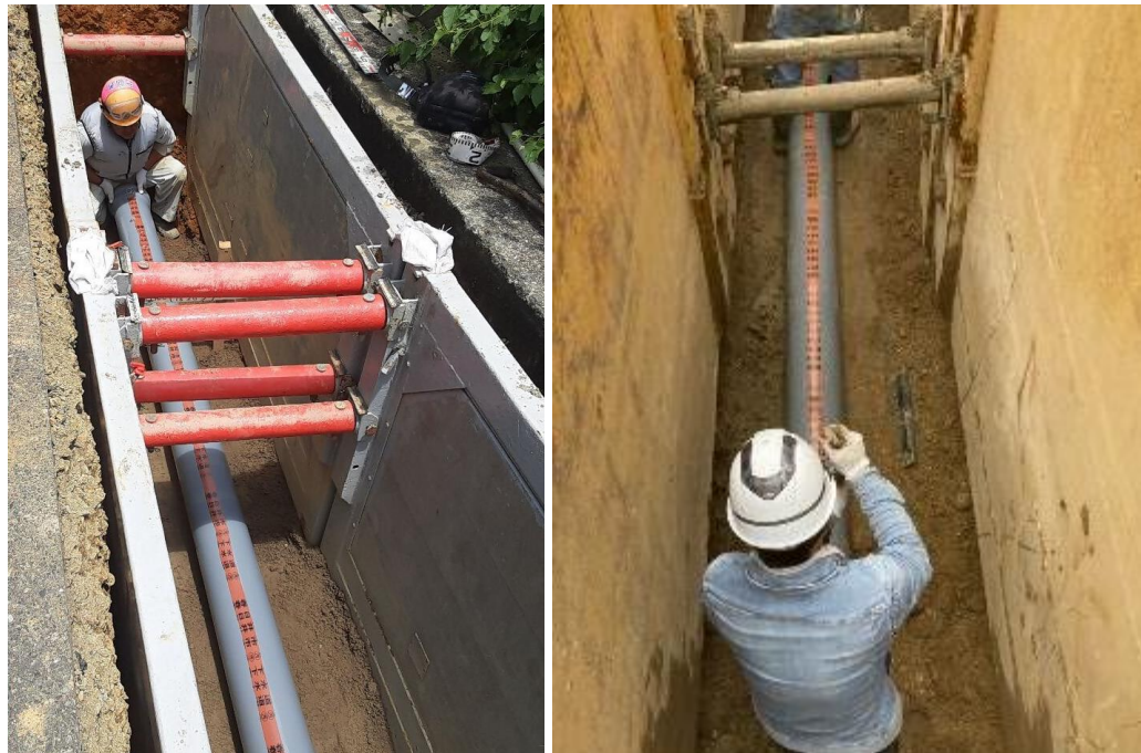
污水管渠工事
