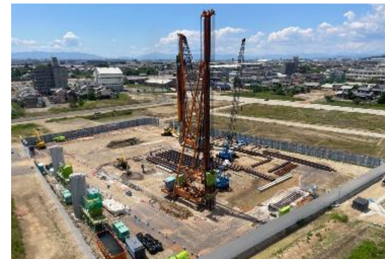
雨水調整池工事
