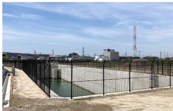
熊野桜佐雨水2号調整池
