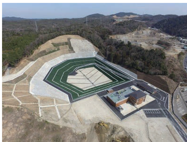
内津北山最終処分場
