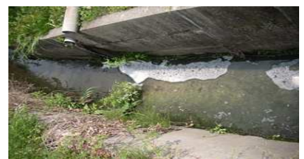
未処理の生活排水が直接放流される側溝
