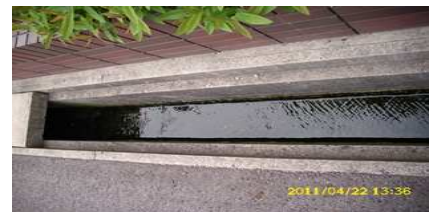
未処理の生活排水が直接放流される側溝
