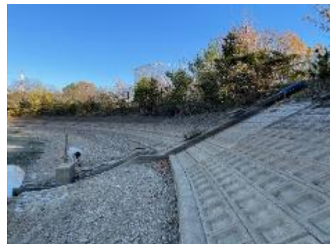
下原大池斜樋（西山町）
