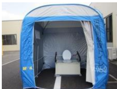
車椅子対応型組立式マンホールトイレ
