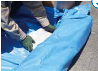
ブルーシートで包み、重し(今回は土のう)を置く
