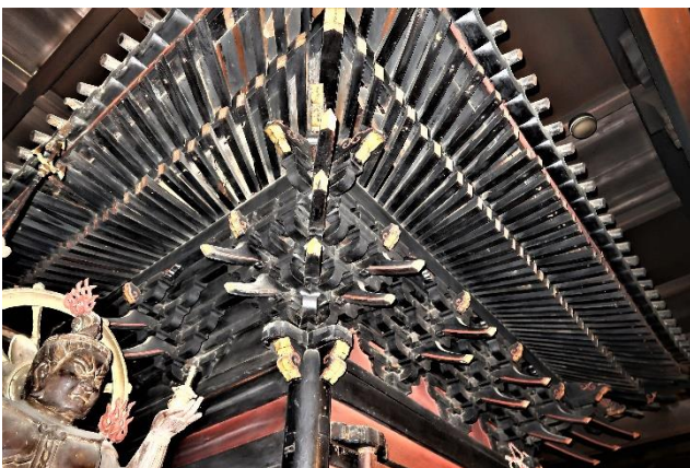
観音堂内厨子 軒見上げ
