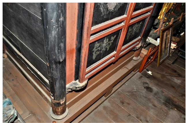
観音堂内厨子 正・側面 柱根部
