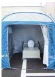
車椅子対応 マンホールトイレ
