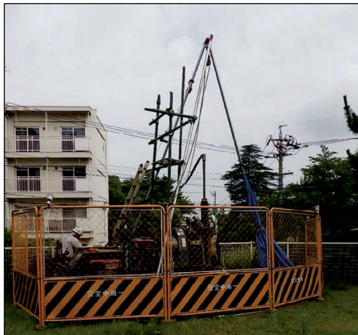
ボーリング機械設置状況
