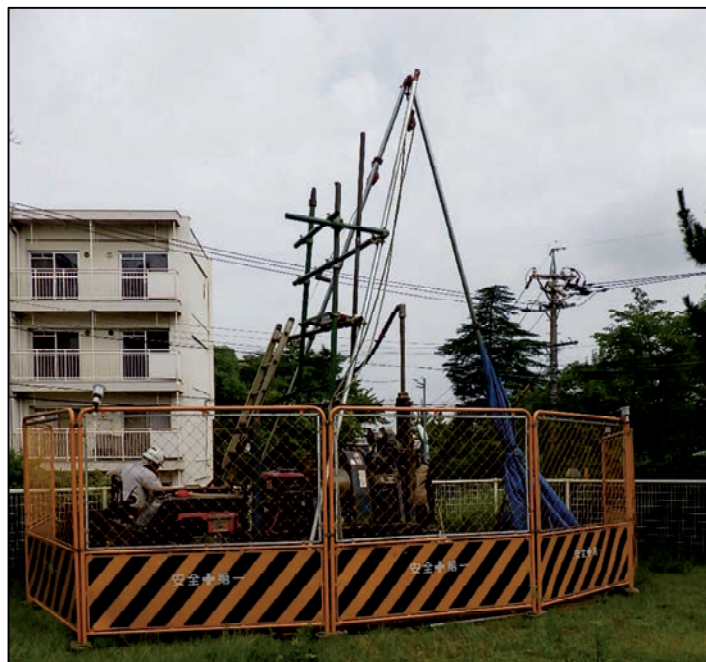
ボーリング機械設置状況 2/2
