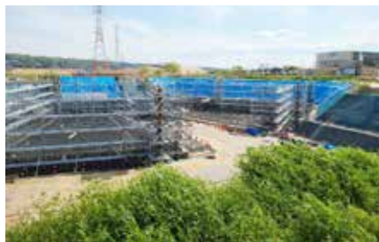
熊野桜佐地区雨水2号調整池
