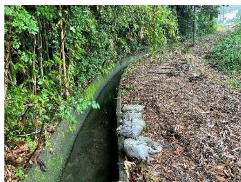
神屋地区排水路
