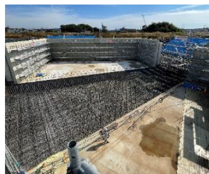
2号調整池（施工中）
