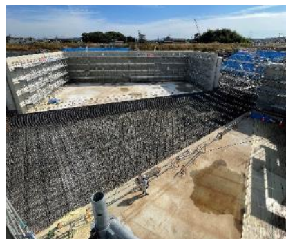
2号調整池（施工中）
