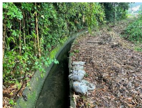
神屋地区排水路
