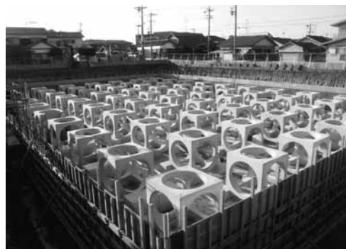
篠田公園雨水貯留施設築造工事 平成23年3月設置
