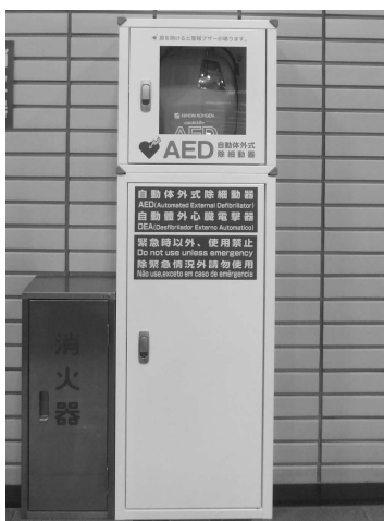
写真2 屋内設置 (専用ボックス有)
