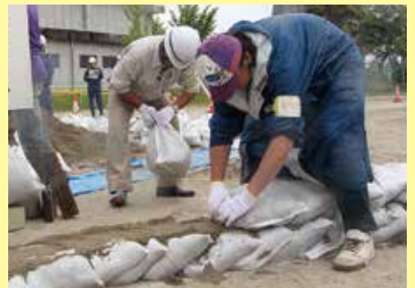
隙間を砂で埋めながら積むとより効果的です▲
