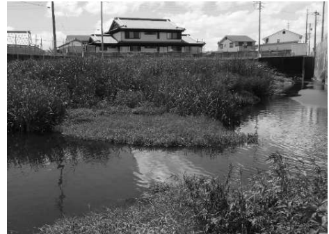
堀ノ内1号調整池
