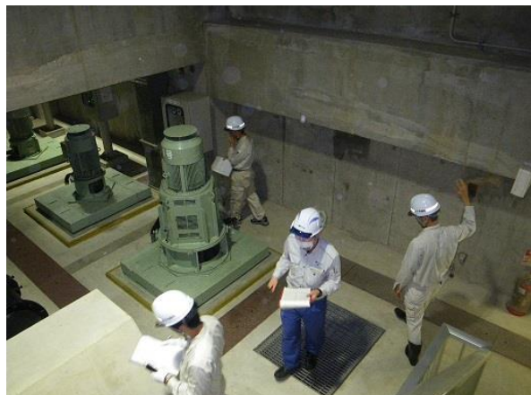
【下水道 BCP 訓練の様子】
