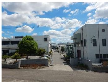
勝西浄化センター
