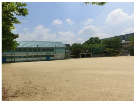
↑ 西側から見た運動場と体育館
