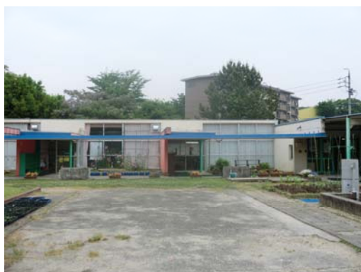
↑ 西南側から見た本館（普通教室）
