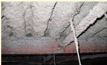
事務室の天井裏
