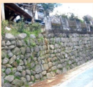
玉石積み擁壁
