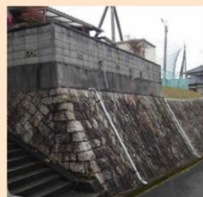
増し積み擁壁
