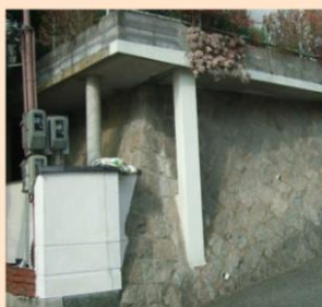
張出し床版付擁壁
