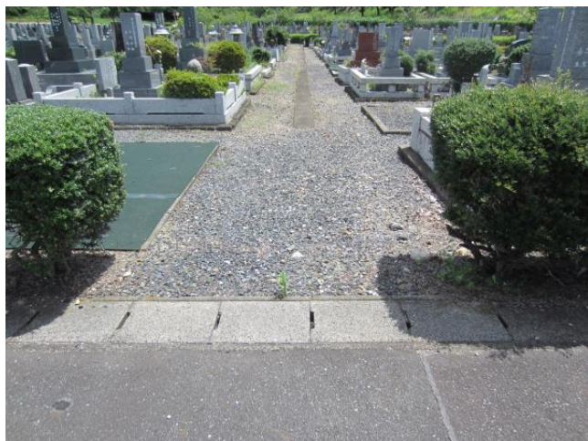
通路舗装前（砂利敷）
