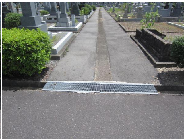
通路舗装後（アスファルト敷）
