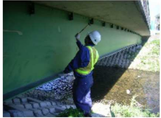
写真-3.2 専門業者による点検状況②
