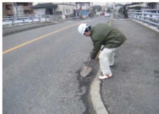
写真-3.4 道路パトロール状況②
