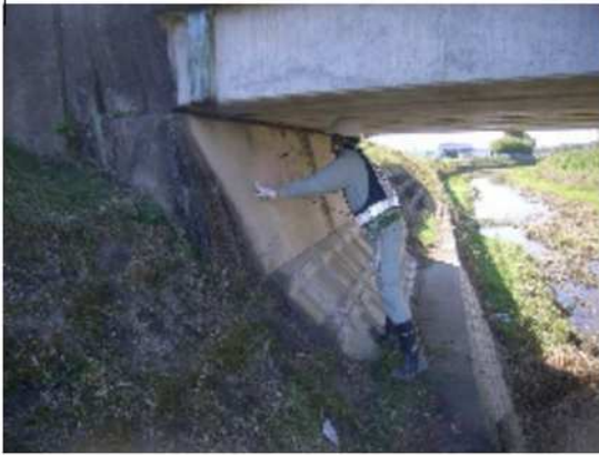
写真-3.1 専門業者による点検状況①
