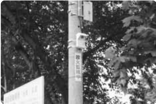
市内に設置されている放火監視機器
