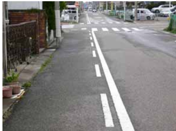
歩行者・自転車通行に配慮した路側帯 (JR春日井駅北)
