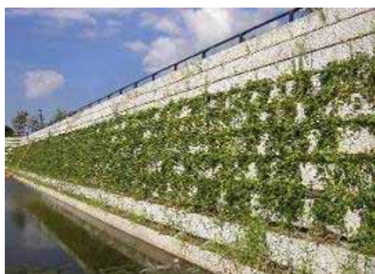
護岸の緑化(植栽ブロック)
