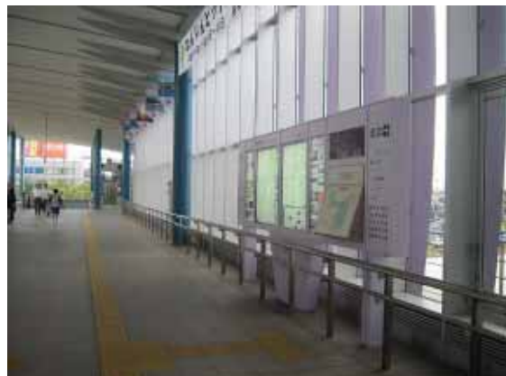
橋上駅と自由通路を整備
